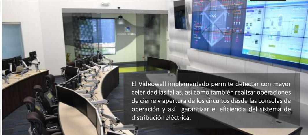
El Videowall implementado permite detectar con mayor celeridad las fallas, así como también realizar operaciones de cierre y apertura de los circuitos desde las consolas de operación y así garantizar el eficiencia del sistema de distribución eléctrica.
